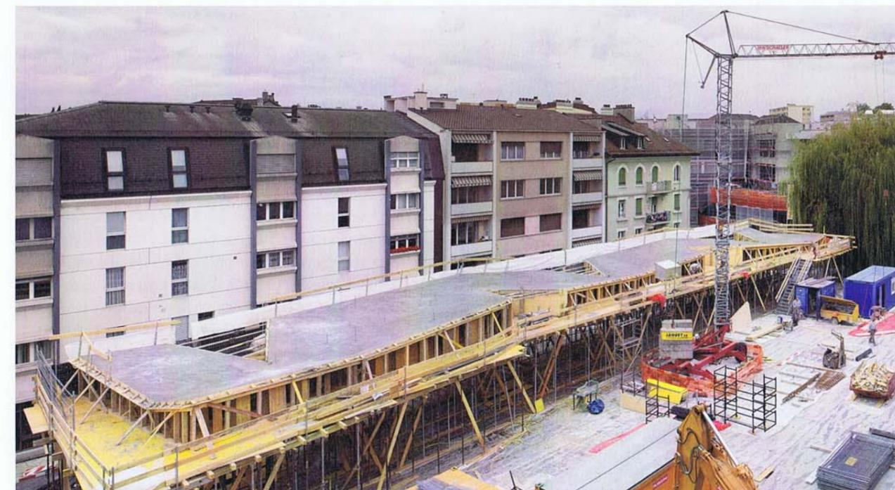
hauteur variant entre 4,5 m et 5 m, sa toiture en béton mince est portée par cinq faisceaux de trois poteaux inclinés. D'une hauteur statique de 15 cm, sa rigidité est assurée par un système de plis qui permet également l'écoulement des eaux de pluie. Cette structure plissée en béton, étudiée en collaboration avec le bureau d'ingénieurs Bonnard et Gardel, s'inspire de solutions structurelles développées dans les années 1970.
